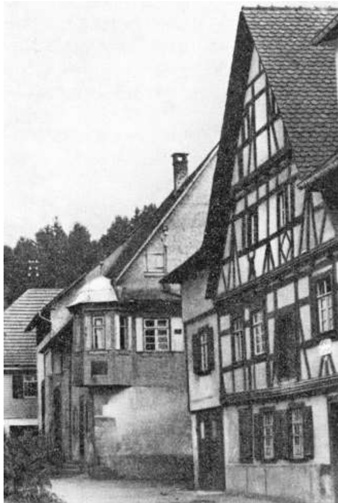
Abbildung 54 Außerhalb des Oppenauer unteren Tors: Allmendmühle und unteres Gerberhaus
