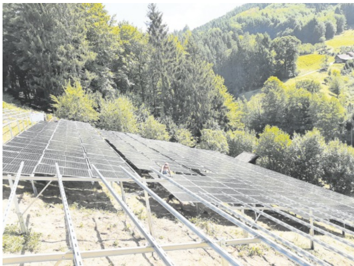
Foto (Renchtal Bürgerenergie): Ein großer Teil der PV-Module der Freiflächenanlage sind bereits installiert.
